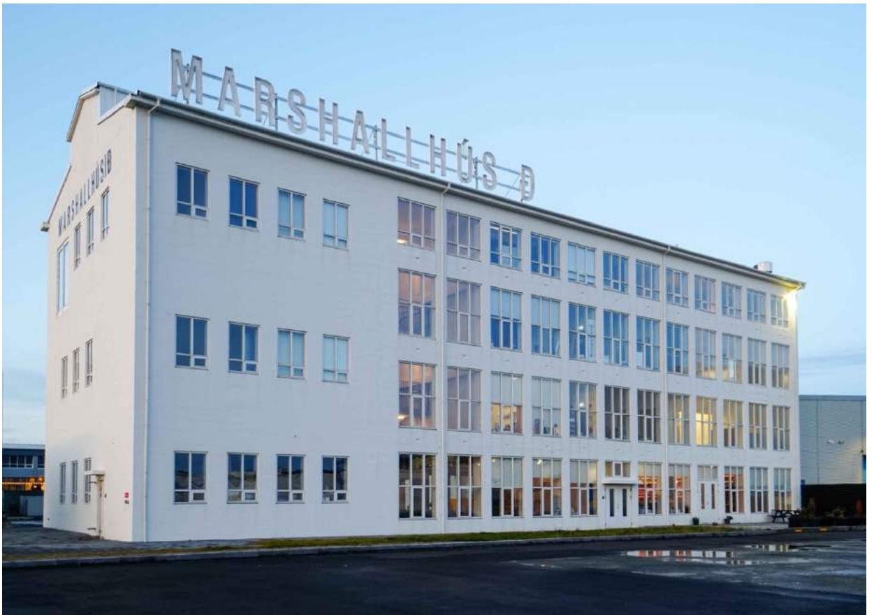
Figure 14: Reykjavik - Marshallhúsið / Marshall House (Kampfner)
